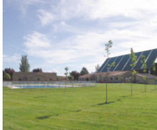
Empleo de placas solares en infraestructuras deportivas.
